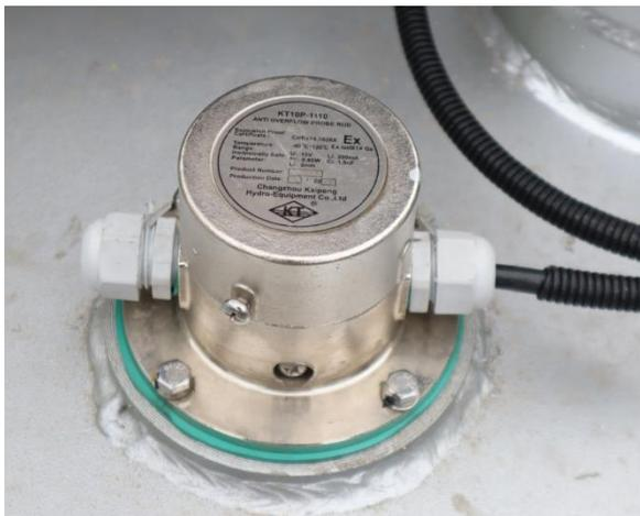
1. 拆除罐体顶部防溢流探杆，避免因高温损坏传感器探头；
